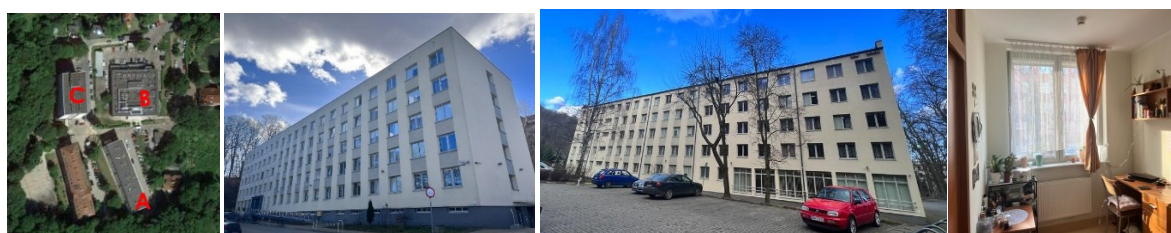
Figura 23: L'edificio del dormitorio (A) - caso di studio per gli studenti della scuola estiva.
