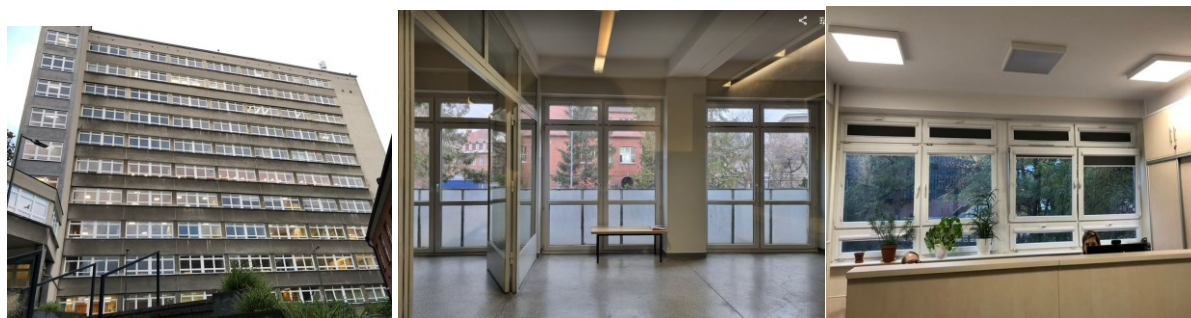
Figura 24: Il caso di studio dell'edificio per uffici per gli studenti della scuola estiva. A. Facciata nord con collegamento all'edificio principale. B. Vista dall'edificio 2° piano con esposizione ad ovest ca. Vista dall'ufficio al 1° piano verso il lato nord e il verde.
